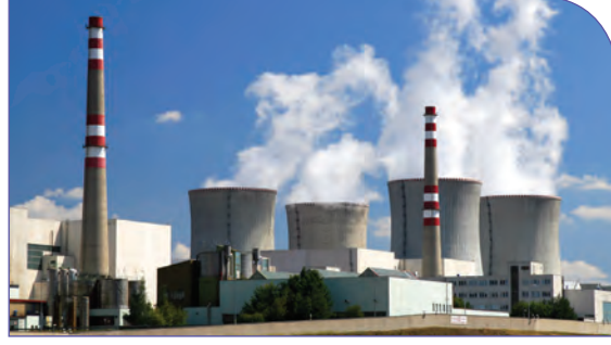
Görsel 1.8: Nükleer enerji santrali
