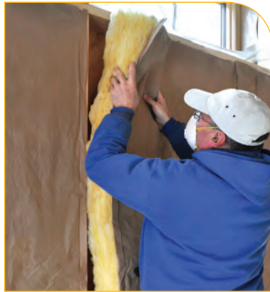
Görsel 5.12: Yalıtım uygulaması
