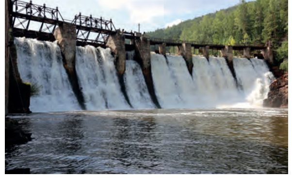
Görsel 4.5.6: Hidroelektrik santrali
