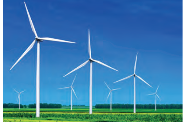
Görsel 4.5.7: Rüzgâr türbini
