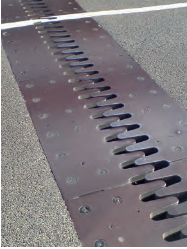
Görsel 5.5.2: Köprü genleşme bağlantıları
